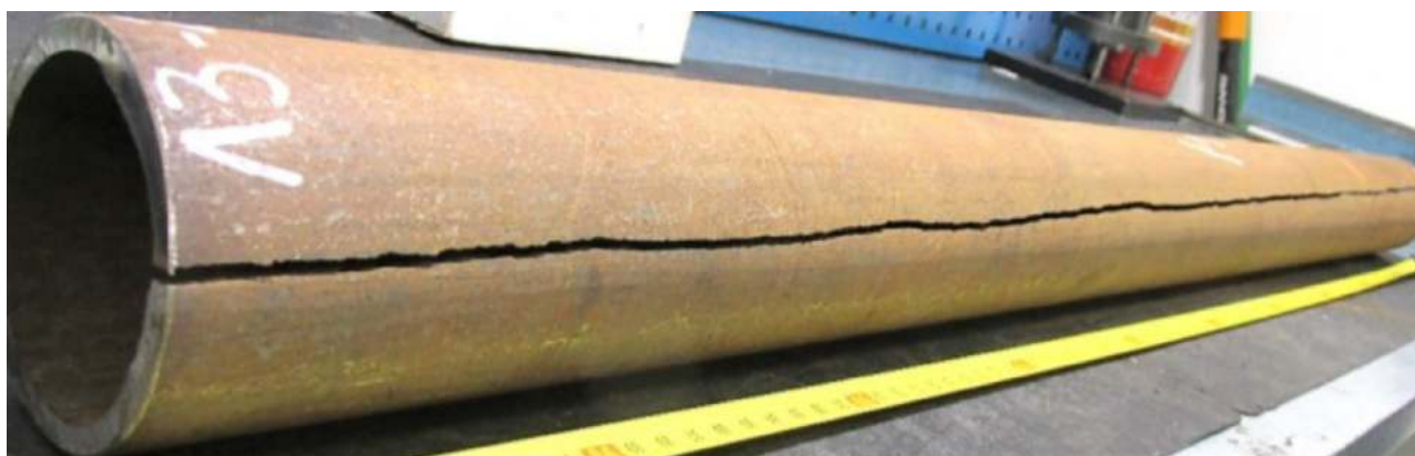
Рис. 5.3: Типичный вид разрушение трубопровода вследствие распространения осевой трещины
