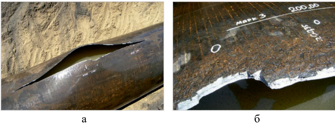
Рисунок 1.4 – Разрушения трубной плиты (а – общий вид; б – очаг разрушения).
